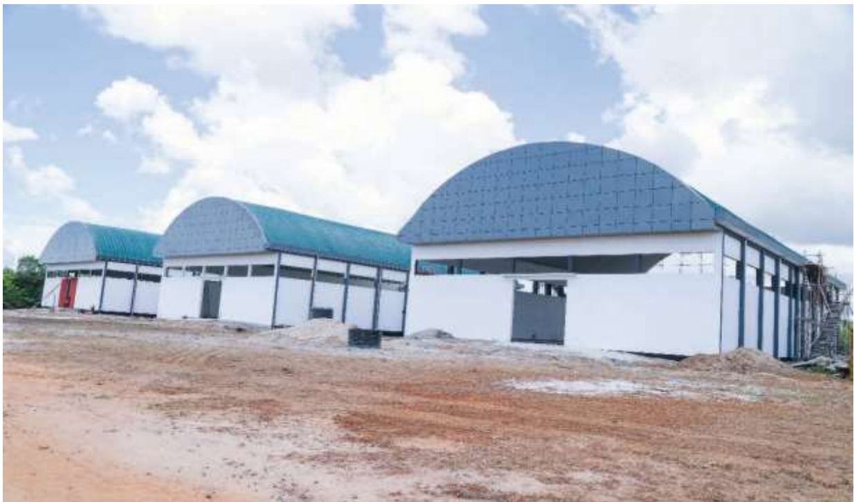
Maghala mapya ya kuhifadhi vifaa vya kijeshi katika Kikosi cha Gongolamboto, Dar- es-Salaam.
